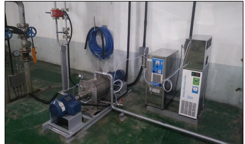
현장 설치 전경
